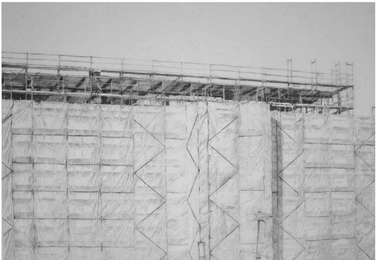
Das Gebäude (mit Bauplane), 2012
