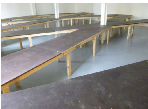
ZIG-ZAG contreplaqué de coffrage filmé antidérapant, chevrons, vis.
